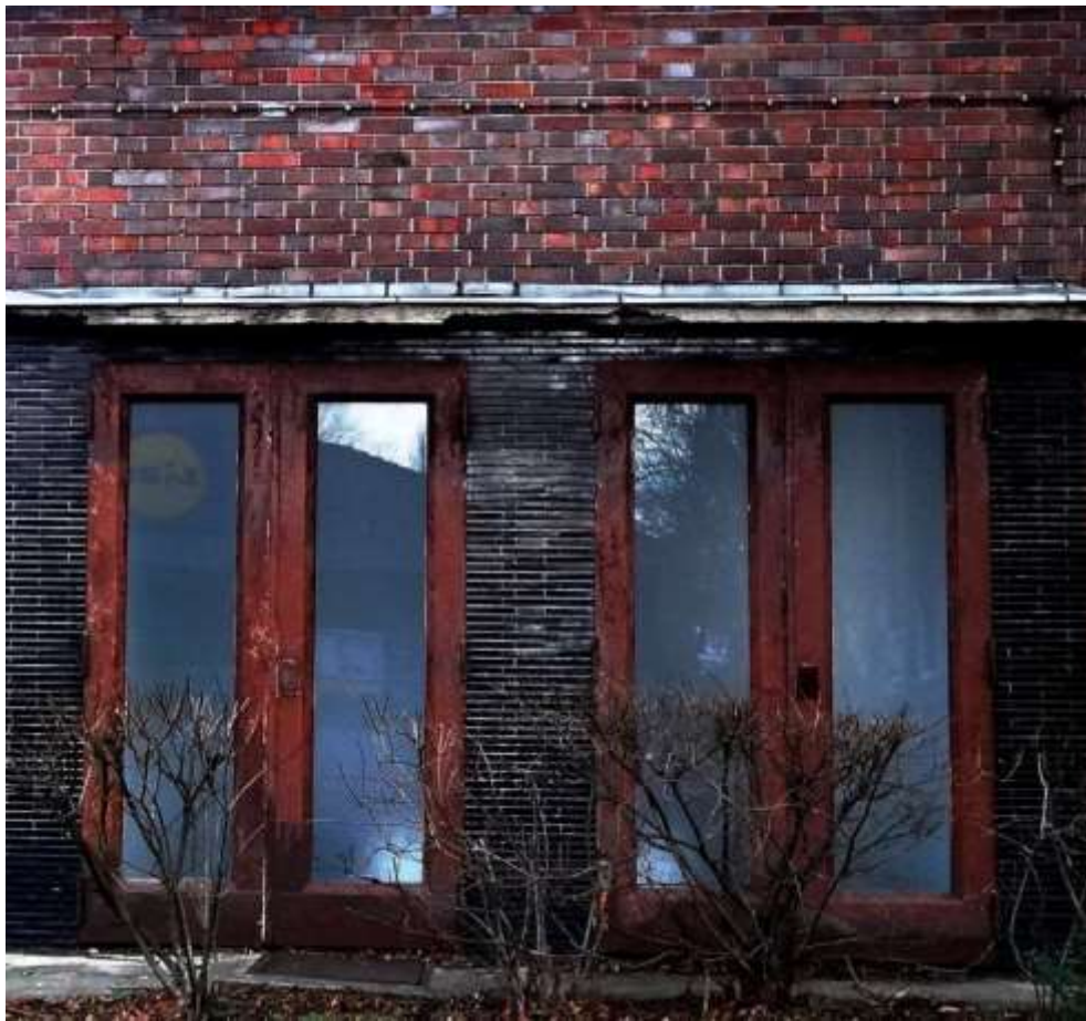
ehemaliges umspannwerk (richard brademann, 1928) (gerviniusstraße)
