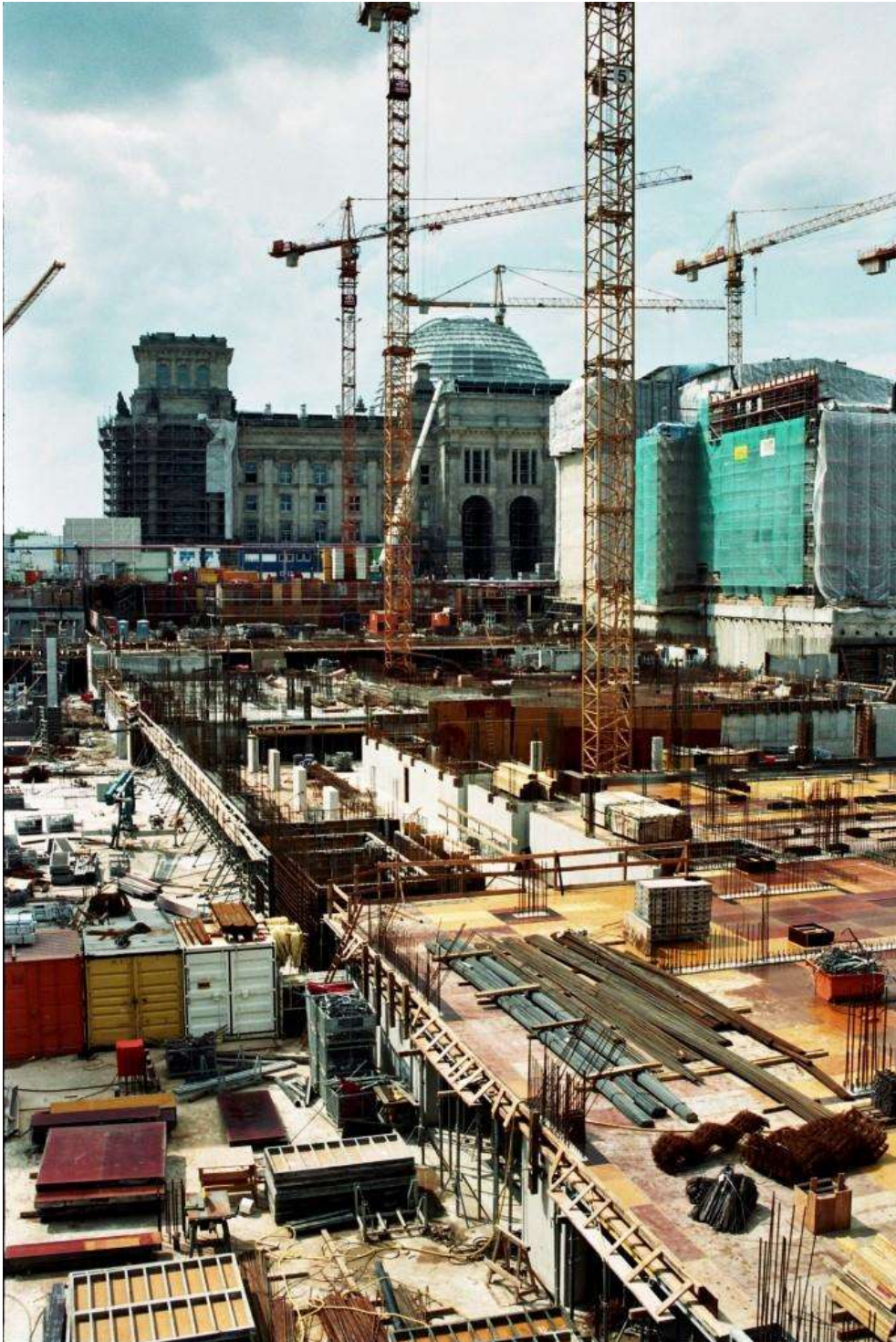
baustelle neues regierungsviertel
